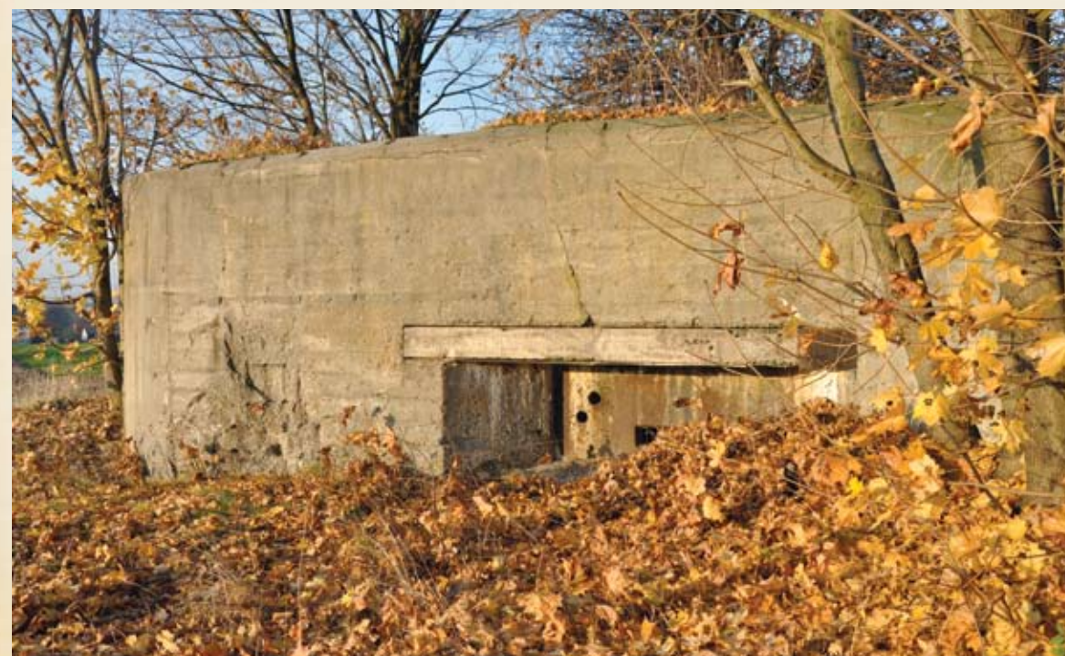
Ściana czołowa bunkra z płytą strzelniczą
